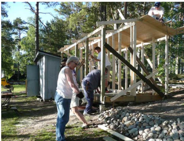
Vid lördagens slut så var taket lagt. Foto: Christer Norman
