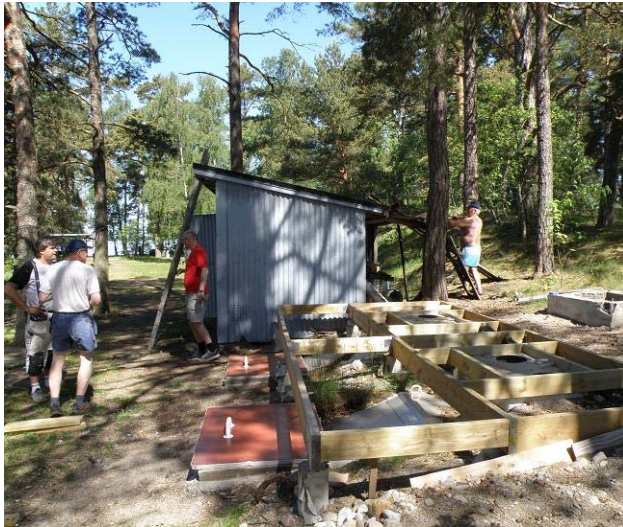
Golvstommen var redan klar när lördagens arbete inleddes med att kapa den utskjutande delen av fiskeboden. Foto: Anders Westerberg
