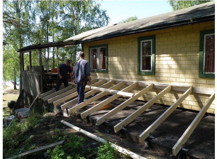
Vid klubbstugan påbörjades ett tak för att skydda bunkern från väta. Foto: Anders Westerberg
